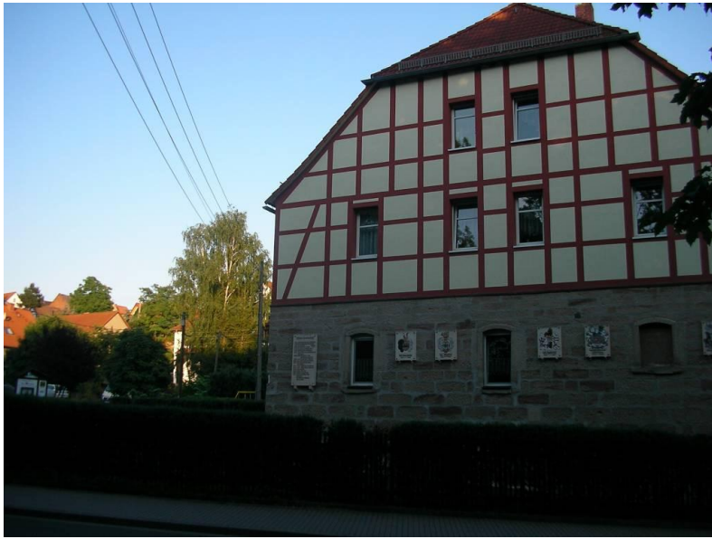
Inspektorhaus (in Privatbesitz, saniert) mit Steintafeln zum geschichtlichen Abriss Drackendorfs und Epitaphen mit den Wappen der zahlreichen Besitzer
